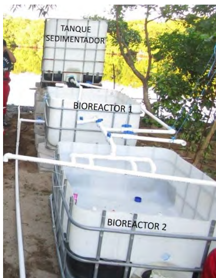
Figura 2. Sistema de Humedal en Construcción
