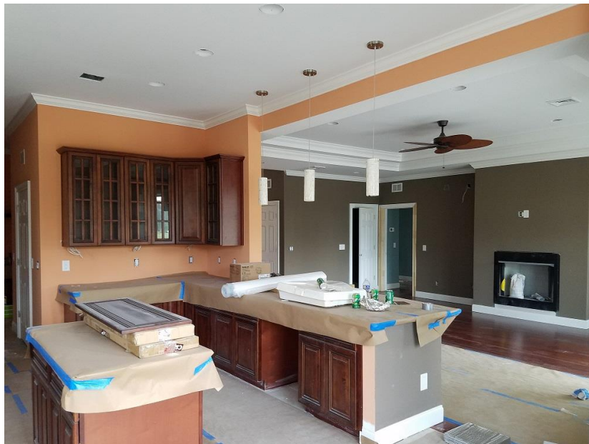
Figura 7.- Proceso de pintura y detalle (Imagen obtenida en trabajo de campo)
