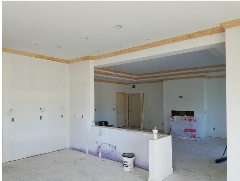
Figura 6.- Proceso de colocación de paredes (Imagen obtenida en trabajo de campo)
