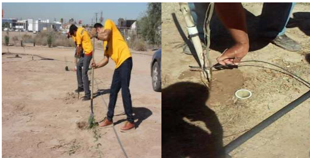
Figura 1b: imagen durante la instalación del sistema de riego
