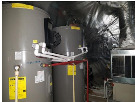
Figura 1.- Colectores Térmicos y GeoThermo (Imagen obtenida en trabajo de campo)
