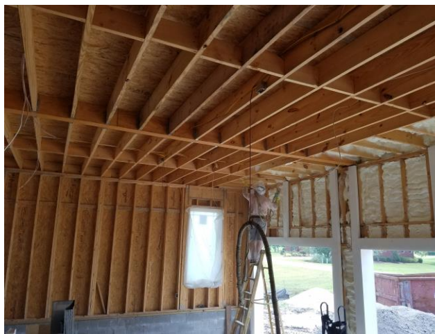
Figura 3.- aplicación en paredes de SFP (Imagen obtenida en trabajo de campo)
