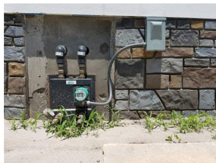
Figura 2.- Bomba de Calor (Imagen obtenida en trabajo de campo)
