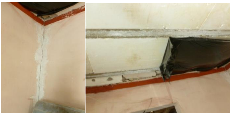
Foto 1 y 2. Al interior de una vivienda con muros de block. Fotografía de las autoras.
