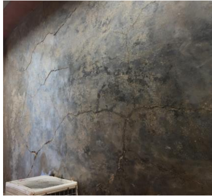
Figura 9. Fisuras y grietas en pisos Fuente: Álbum fotográfico propio.
