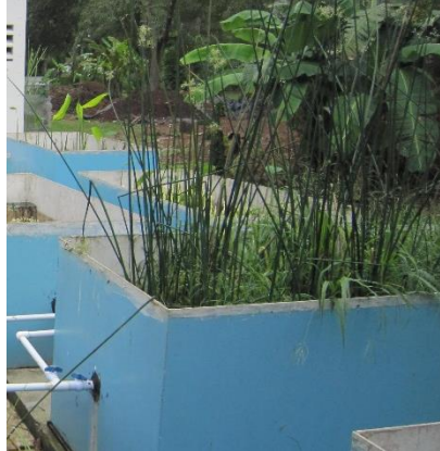
Figura 6.- Humedal Artificial de flujo subsuperficial con Cyperus articulatus (chintul) y Paspalum paniculatum (camalote).
