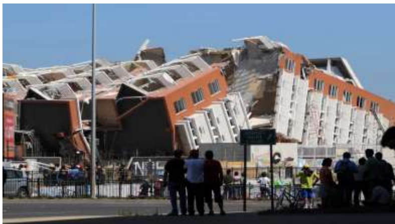
Figura 2. Desplome del edificio Alto Río.
