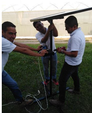
Figura 13. Perforado para insertar el cable de forma oculta
