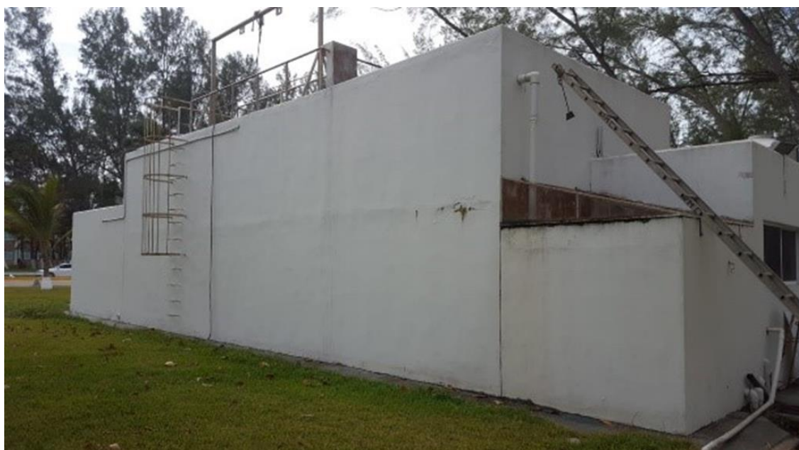
Figura 3. Fotografía de la Planta Residual instalada en la Heroica Escuela Naval Militar, en Veracruz México.
