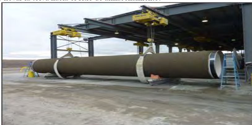
Figura 2 cemento aplicado en el proceso de Coating.
