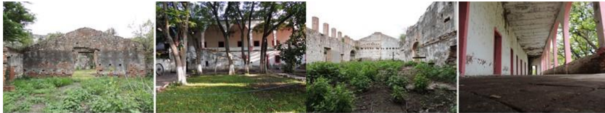
Figura 3: Interior de la hacienda. Casa de Purga y Casa Principal
