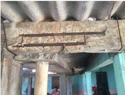
Figura 11. Corrosión del acero. Fuente: Álbum fotográfico propio.
