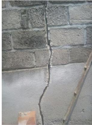
Figura 8. Fisuras y grietas en muros. Fuente: Álbum fotográfico propio.
