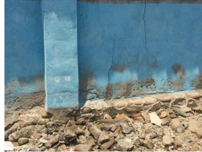
Figura 6. Fisuras y grietas en muros
