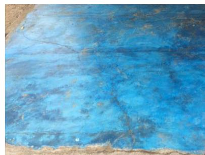
Figura 4. Fisuras y grietas en pisos
