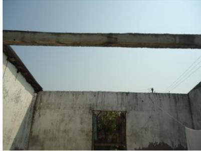
Figura 5. Perdida de cubierta.
