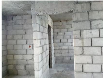
Figura 12. Falta de soportes estructurales Fuente: Álbum fotográfico propio.
