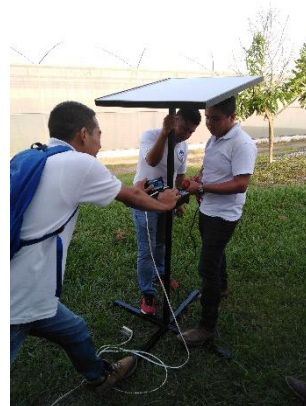
Figura 14. Instalación y fijado de material, conexiones para su correcto funcionamiento.
