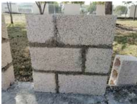
Figura 7. Levantamiento de MBP de 60x60 cm
