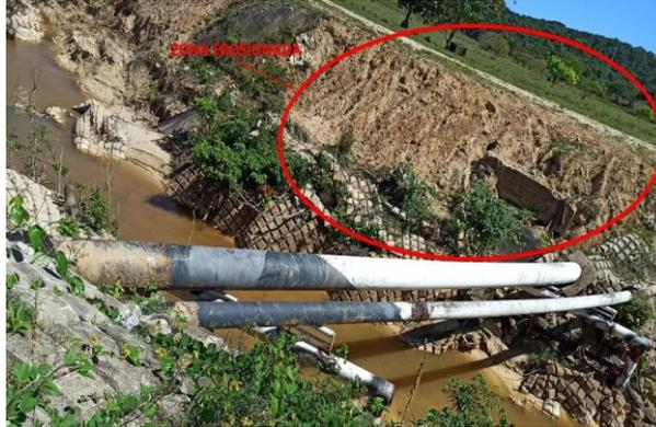
Figura 3. Zona erosionada que disminuye el soporte necesario para las tuberías, causando deformaciones excesivas en las tuberías.
