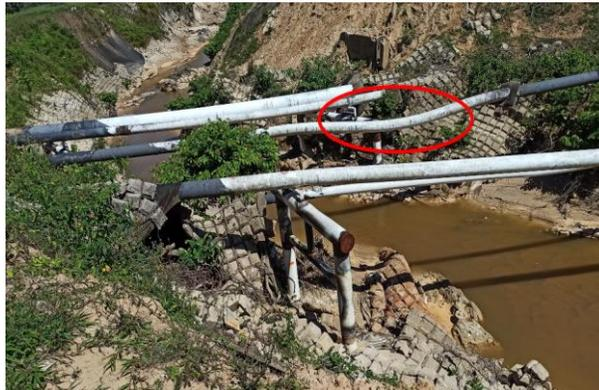
Figura 2. Sistema de tuberías de transporte de hidrocarburos. Oleoducto de 10'' de diámetro con deflexión plástica.
