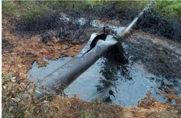
Figura 1. Falla típica de un oleoducto.
