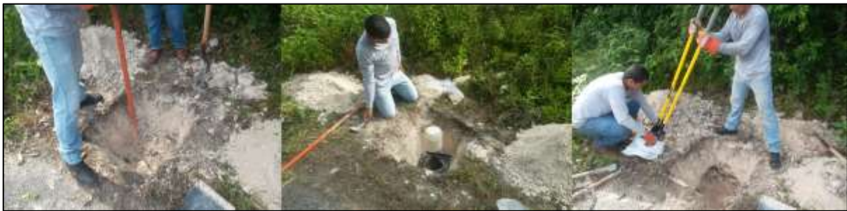
Figura 3 Pozos a cielo abierto en hombros de camino existente
