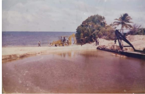
Imagen 1. Trabajos de apertura en la creación del Canal de Zaragoza
