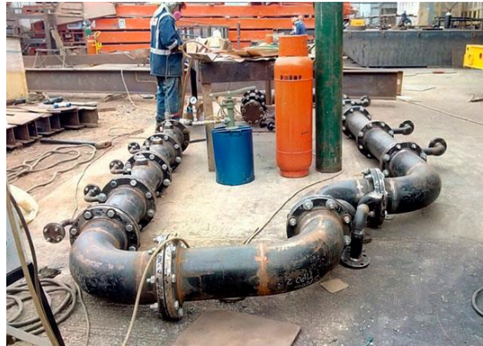
Figura 1 Spool de tuberías.
