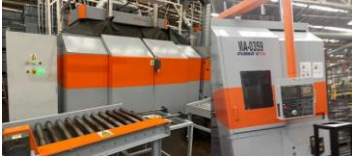
Ilustración 14; Montaje de equipos en área de producción. (Fuente Propia)
