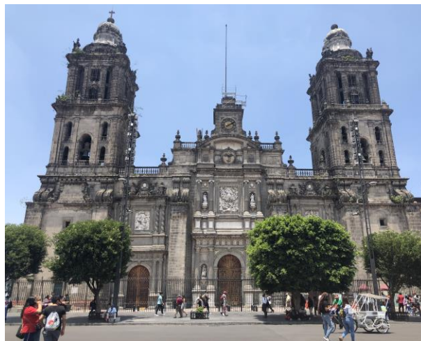
Figura 3 Fachada Principal de la Catedral Metropolitana
