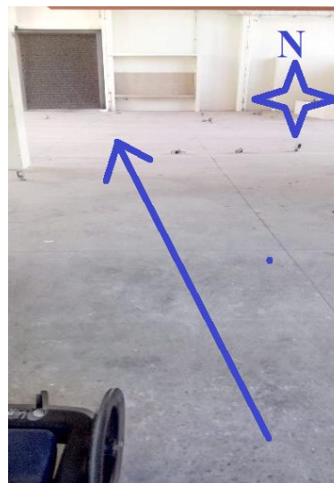
Figura 2. Interior del edificio nuevo de Ingeniería Mecánica. La flecha azul ilustra la dirección de movimiento del georadar.
