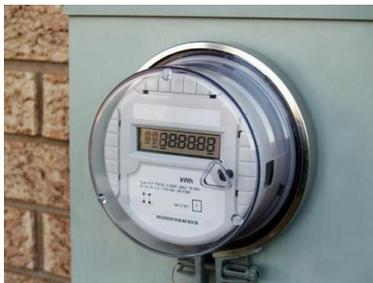
Figura 4.- Medidor bidireccional de sistema de interconexión
