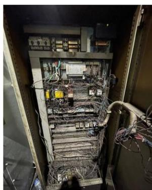
Ilustración 3; Exceso de suciedad en el interior de tablero de control. (Fuente Propia)
