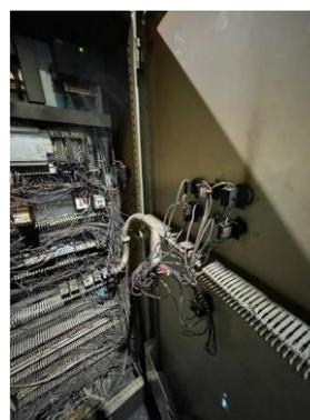
Ilustración 4; Daño en canaletas y cableado fuera de lugar. (Fuente Propia)
