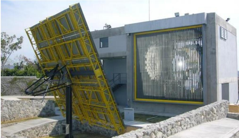
Figura. 1. Vista exterior del HSAFR donde se aprecia el heliostato, el atenuador y el concentrador.
