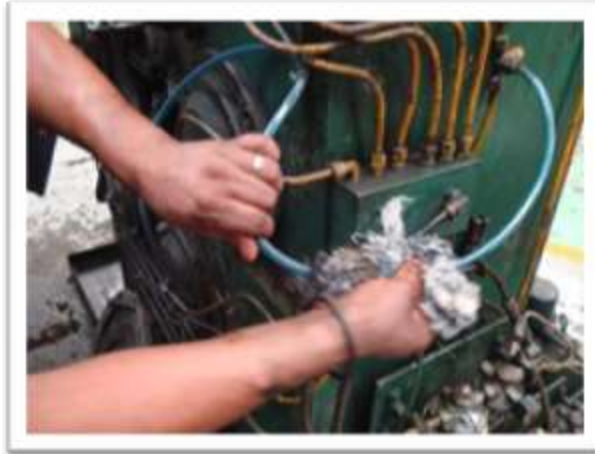
Figura 7. Limpieza e inspección de las condiciones de las mangueras.
