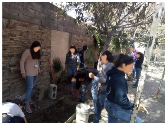
Ilustración 4. Construcción de banca para parque de la colonia Chihuahua 2000.
