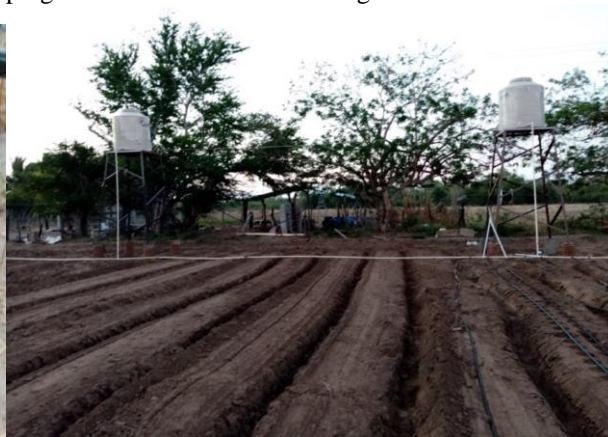
Figura 3. Tubos PVC conectados a tinacos.
