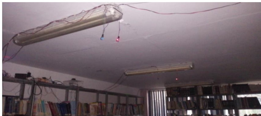
Figura 2.- Ubicación de los sensores en la biblioteca del CETis No. 15
