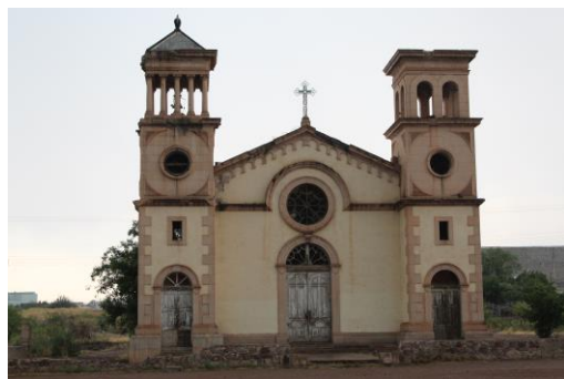
Ilustración 13 Fachada de la Capilla de San Carlos Borromeo en la ex hacienda Quinta Carolina, se observa la belleza de sus detalles, pero sobre todo la diferencia de sus torres en el último cuerpo. Fuente: JNVM (2020)
