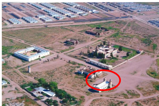
Ilustración 4 imagen aérea de lo que queda de la ex hacienda mostrando las construcciones para contextualizar su ubicación. La Quinta y lo que fue la sala de boliche se observa que está delimitado todo su espacio por un murete, la Capilla de San Carlos Borromeo (con un óvalo rojo) Fuente: Colección particular FMRP (2010)
