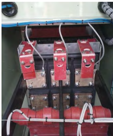
Figura 8. Soportes para sensores infrarrojos
