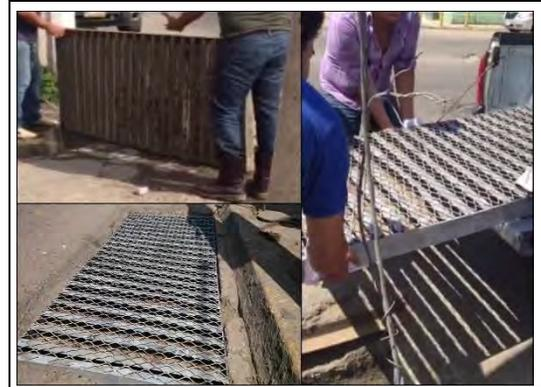
Figura 3. Retiro, transporte e instalación de la rejilla rediseñada del colector.
