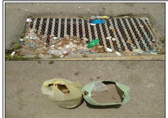
Figura 5. Muestra de los residuos captados por la rejilla rediseñada.
