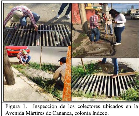
Figura 1. Inspección de los colectores ubicados en la Avenida Mártires de Cananea, colonia Indeco.
