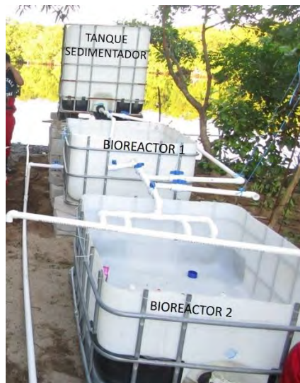
Figura 2. Sistema de Humedal en Construcción
