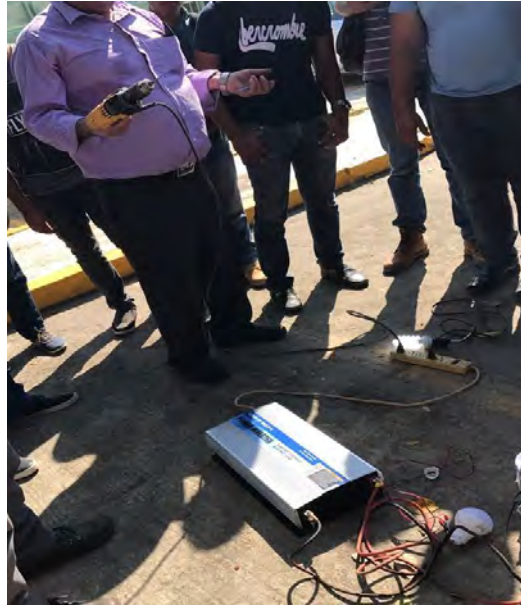
Figura 6. Finalmente podemos utilizar la energía eléctrica generada por los paneles solares en el funcionamiento de las herramientas eléctricas, utilizadas en cualquier obra de edificación.
