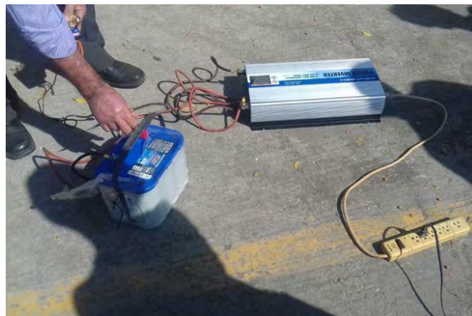
Figura 5. La energía captada por los paneles solares es almacenada por la batería de ciclo profundo, transmitiéndola al inversor que convierte la energía de 12 V a 110 V. Fuente: elaborado por autores.
