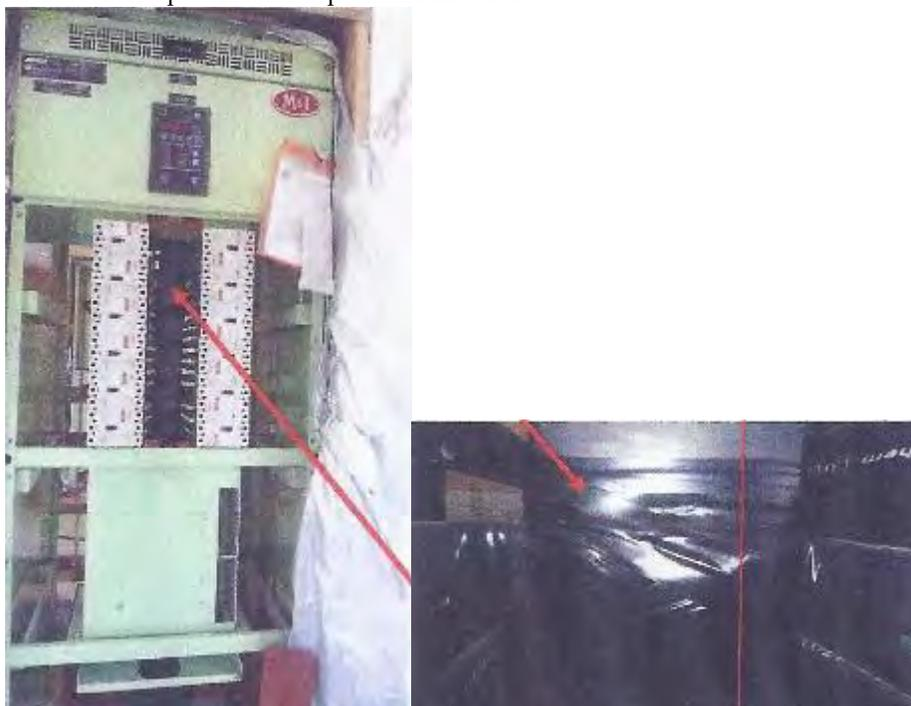
Figura 4. Encintado fuera de norma de barra principal.
