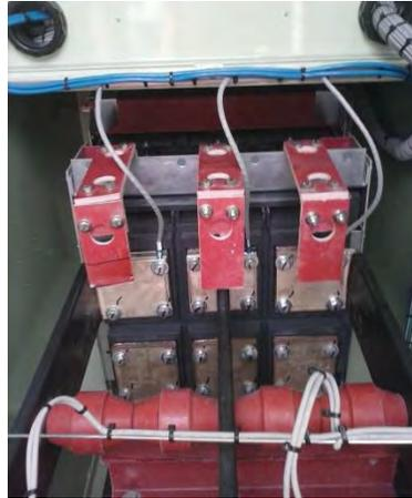
Figura 8. Soportes para sensores infrarrojos
