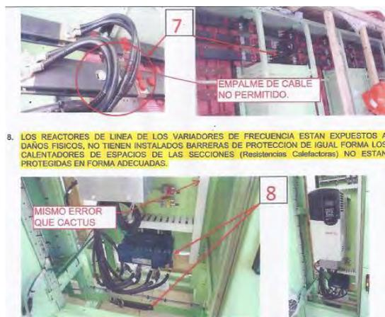
Figura 3. Observaciones del inspector al panel posterior del CCM.
