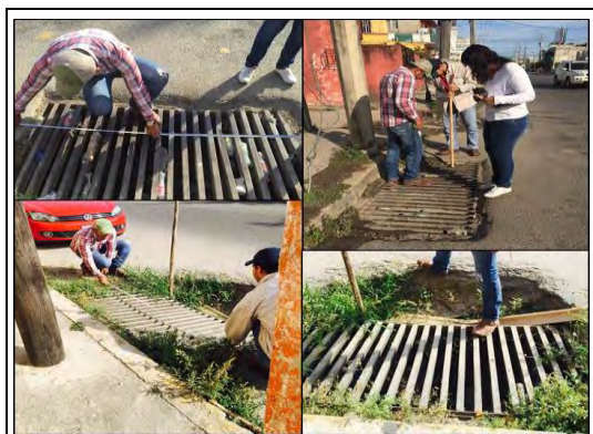
Figura 1. Inspección de los colectores ubicados en la Avenida Mártires de Cananea, colonia Indeco.
