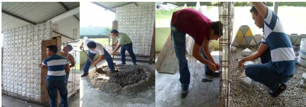
Figura 3. Construcción de prototipo con paneles ecológicos escala 1:1 de 5.50 m x 2.50 en el Instituto Tecnológico de Villahermosa. Foto tomada por autores.
