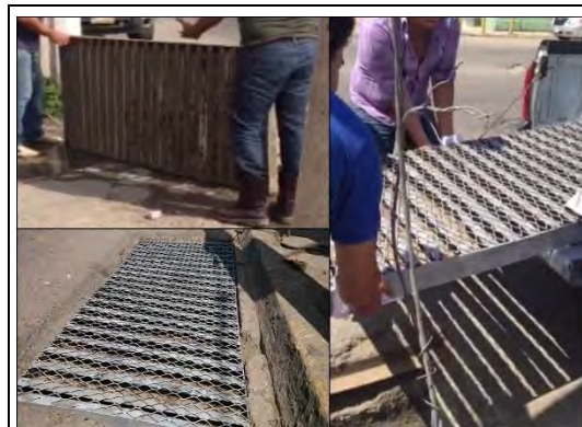
Figura 3. Retiro, transporte e instalación de la rejilla rediseñada del colector.
