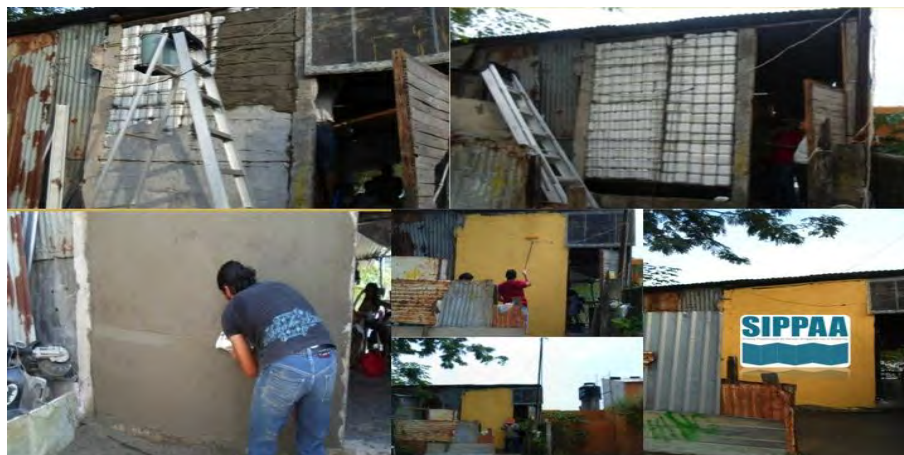
Figura 3. Aplicación del sistema ecológico en una casa en la ciudad de Villahermosa Tabasco. Foto tomada por autores.
