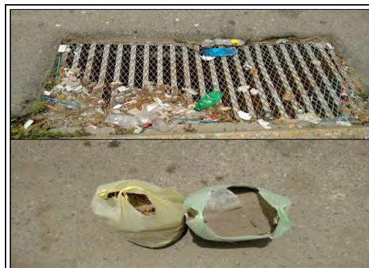
Figura 5. Muestra de los residuos captados por la rejilla rediseñada.
