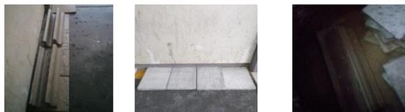
Figura 5.- Fraguado inicial y curado de losetas y molduras.
