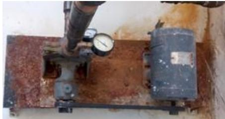
Figura 1. Bomba centrífuga de  $\frac{3}{4}$ " HP
