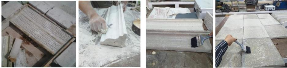
Figura 6.- Rayado, lijado y aplicación de resina en losetas y molduras.
