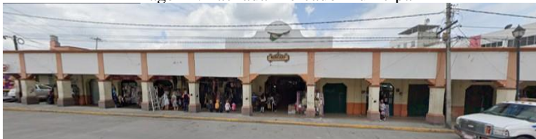
Imagen 1. Fachada Mercado Municipal
