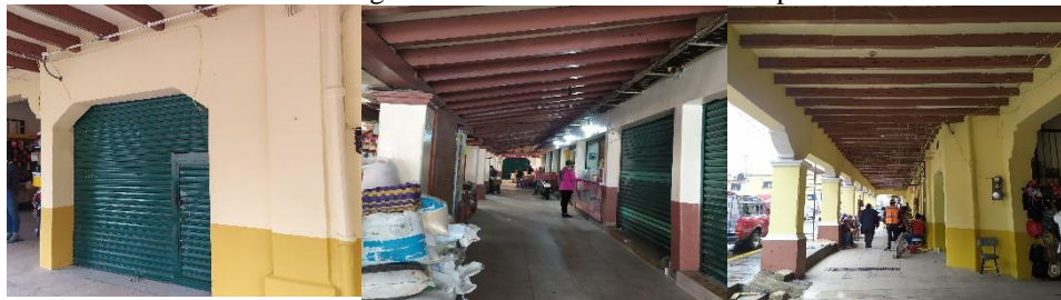
Imagen 3. Muros del Mercado Municipal
