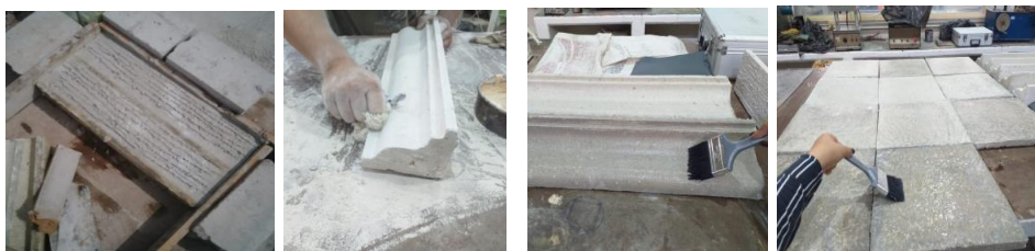
Figura 6.- Rayado, lijado y aplicación de resina en losetas y molduras.
