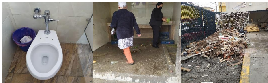
Imagen 7. Sanitarios interior y exterior
