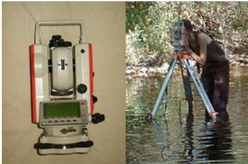
Figura 2. Levantamiento topográfico con estación total.
