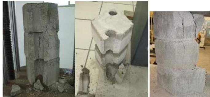
Figura 10. Patrón de colapso en pilas
