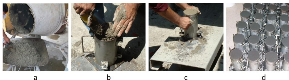
Figura 1. Proceso de elaboración de probetas, a) elaboración de la mezcla, b) llenado de moldes, c) vibrado, d) probetas coladas
