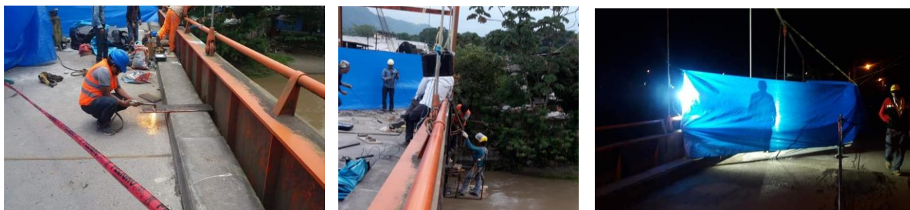
Figura 5. Ejecución de actividades de reparación. Fuente: De autores (2020)
