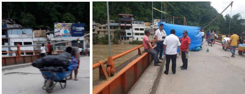
Figura 6 Forma de traslado de los productos debido a la restricción vehicular del puente. Fuente: De autores (2020)
