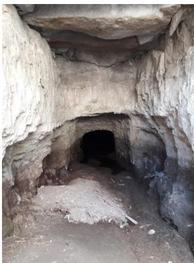
Figura 3 Interior de la galería, azolvada, se observa el sistema de trabajo del socavón y el techo de cantera.
