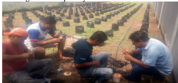
Figura 5. Instalación de sistema de riego
