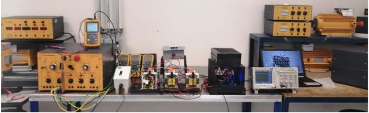
Figura 6. Arreglo de transformadores monofásicos, y sus demás componentes para la alimentación trifásica, carga y adquisición de dato.
