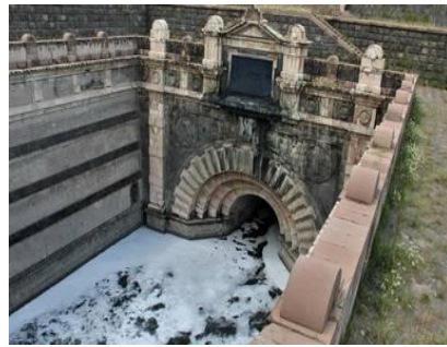
Figura 3 Caja de Agua https://www.elsoldetoluca.com.mx/local/obra-hidraulica-del-porfiriato-sigue-en-pie-y-operando-en-zumpango-1932942.html
