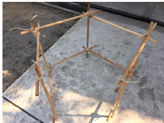
Figura 3. Ensamble de 4 módulos prefabricados
