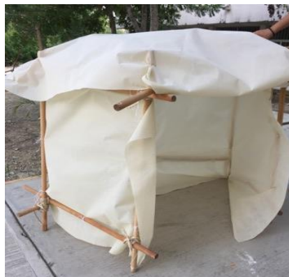
Figura 5. Cubierta con membrana textil
