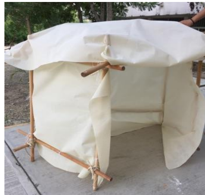
Figura 5. Cubierta con membrana textil
