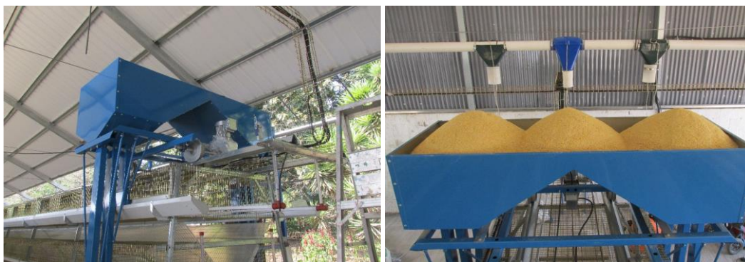
Figura No. 7. Construcción final y carga de alimento de la tolva
