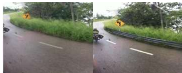
Observamos como una curva de la vía se encuentra enmontada y no se ve el señalamiento restrictivo, ni la barrera de contención, y la pintura separadora de carril, ya no se aprecia, las mejoras son todas las observaciones detectadas y corregidas.
