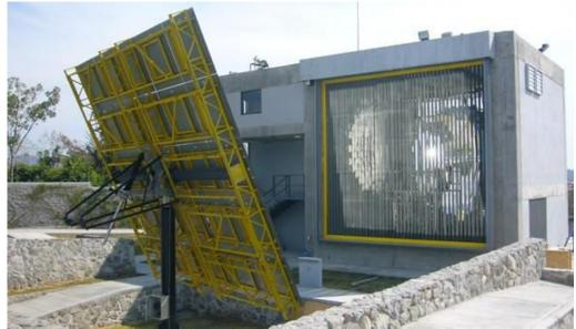
Figura. 1. Vista exterior del HSAFR donde se aprecia el helióstato, el atenuador y el concentrador.
